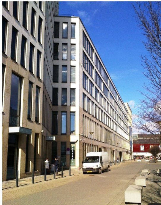
Obr.5 Budova s dvojitým pláštěm
