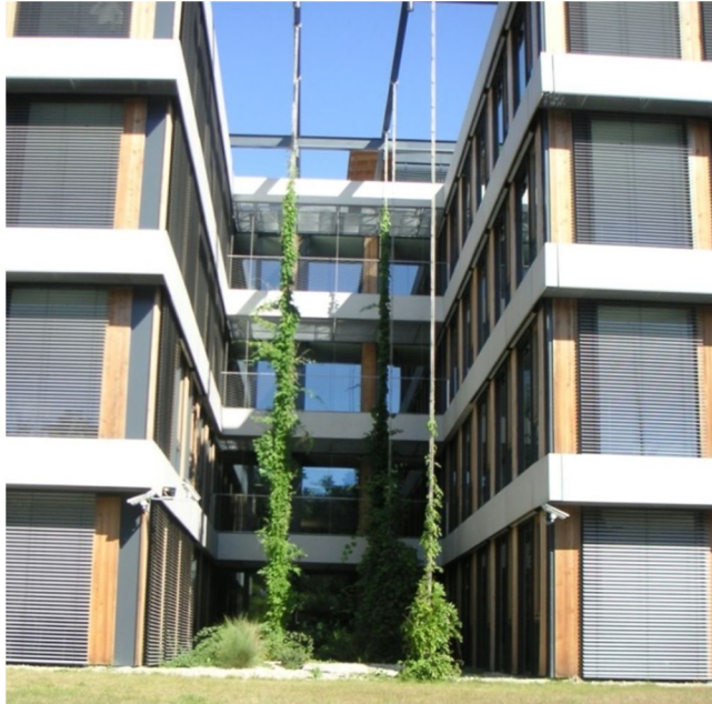
Obr.7 Na zastíněných oknech jsou žaluzie svinuty
