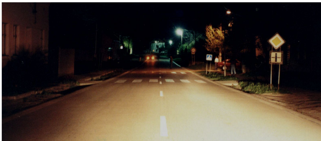
Obr.10 Nerovnoměrné osvětlení vozovky, chodec v tmavém místě, [5]
