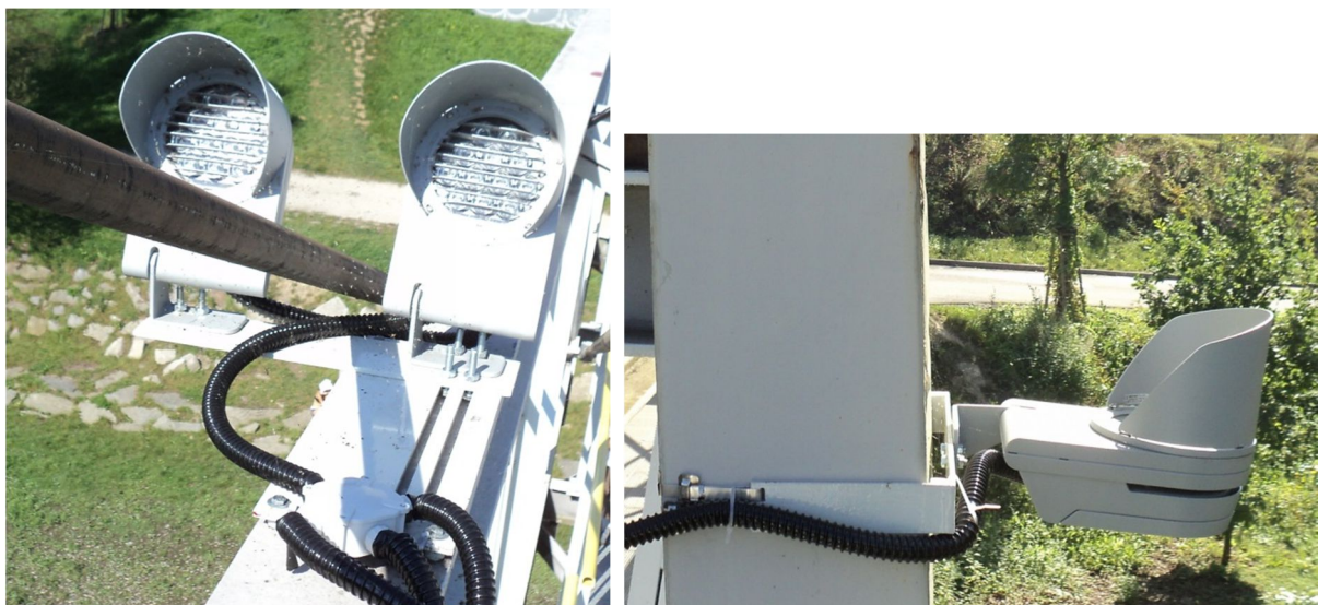
Obr.5 Finální upevnění svítidel
