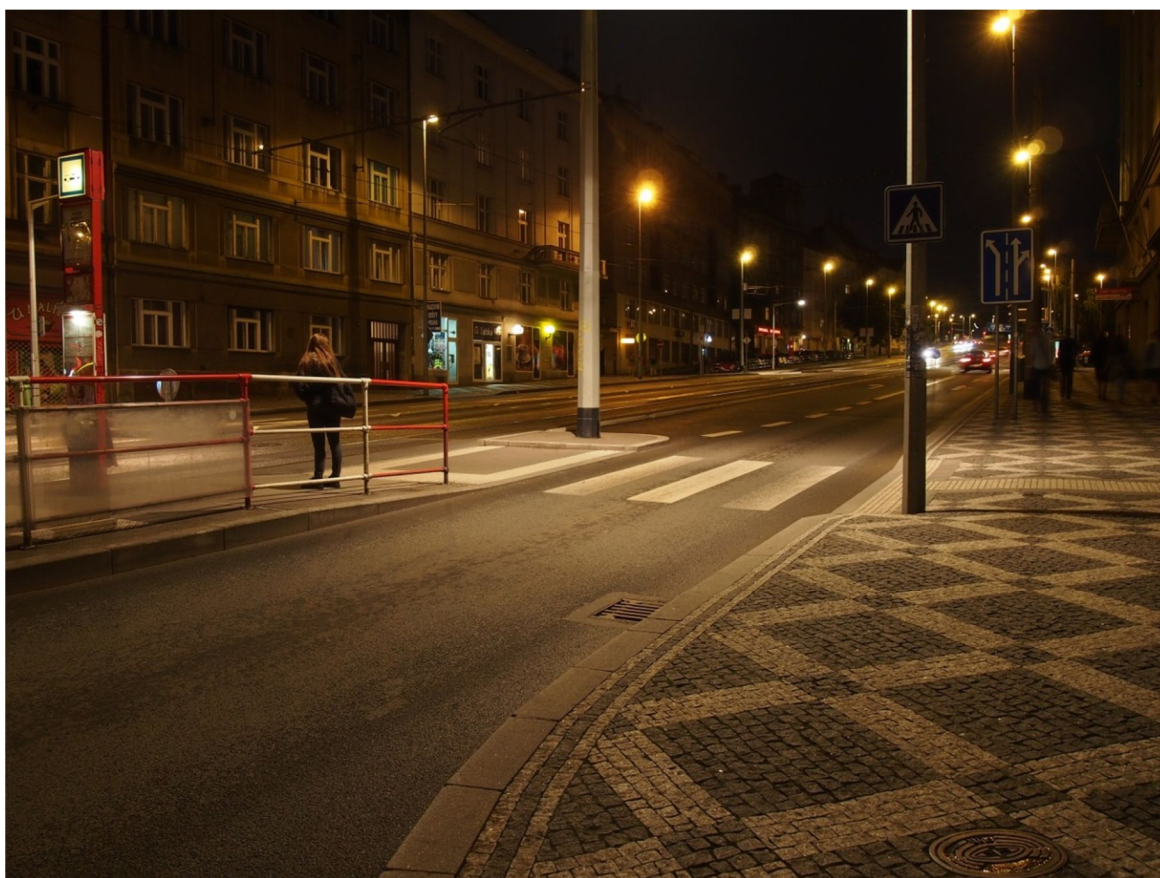
Obr.1 Osvětlení chodců na přechodu podle TKP 15.
