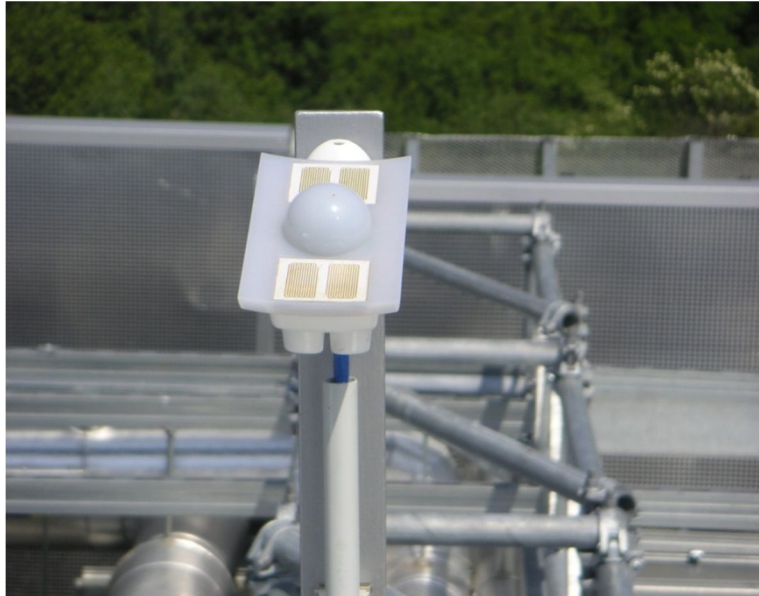
Obr.3 Kombinovaný snímač povětrnostních údajů předává měřená data KNX systému pro další zpracování
